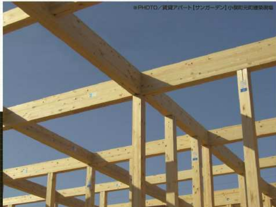
※PHOTO／賃貸アパート【サンガーデン】小俣町元町建築現場
